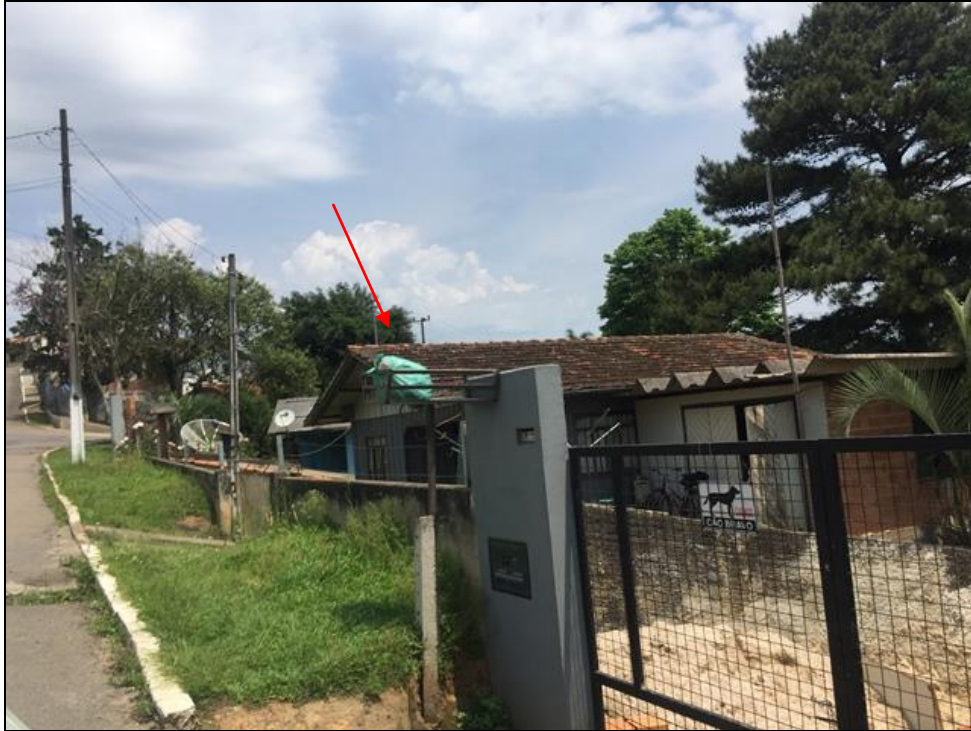
Figura 15 – Acondicionamento de RSU em lixeira específica Fonte: Premier Engenharia, 2019.
