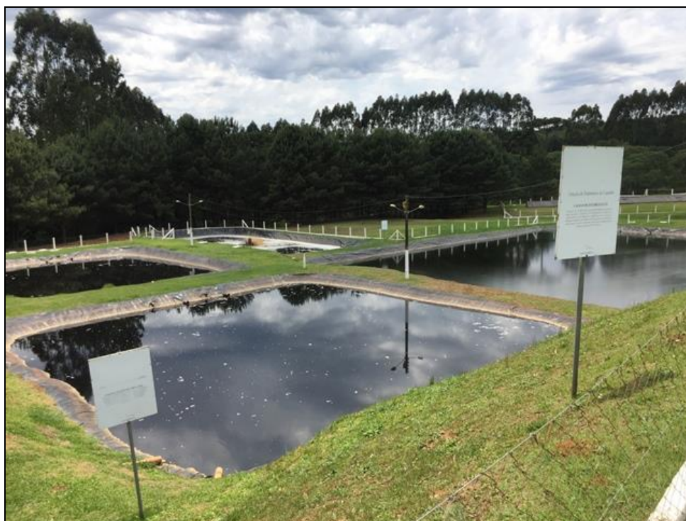
Figura 29 – Estação de tratamento de chorume Fonte: Premier Engenharia, 2019.
