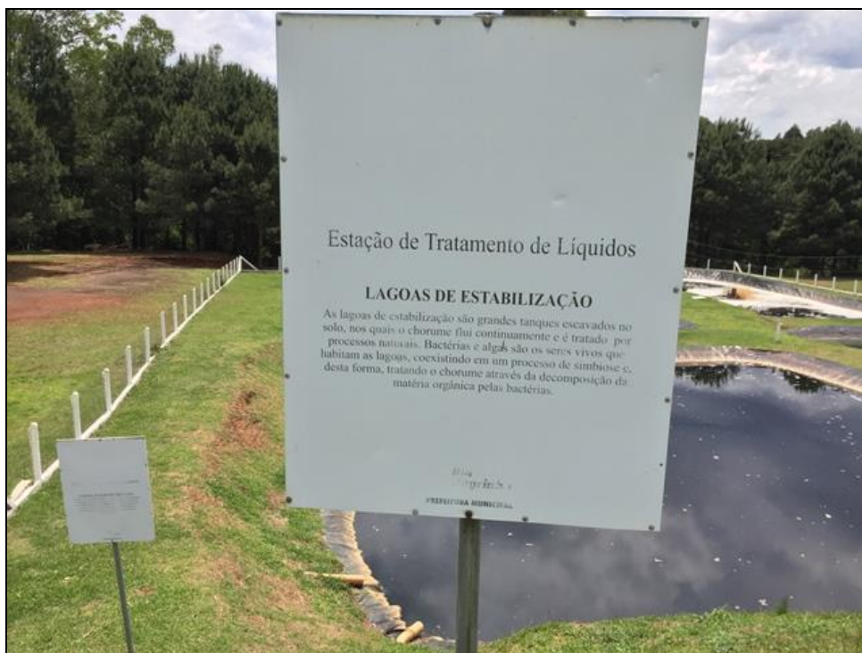
Figura 43 – Aterro sanitário municipal (sistema de tratamento de chorume) Fonte: Premier Engenharia, 2019.
