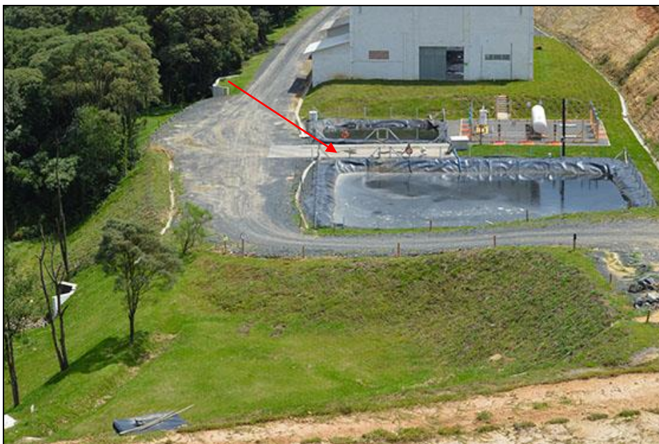
Figura 49 – Aterro da Empresa Hera Sul (lagoas de armazenamento temporário de percolados e efluentes) Fonte: Empresa Hera Sul, 2019.
