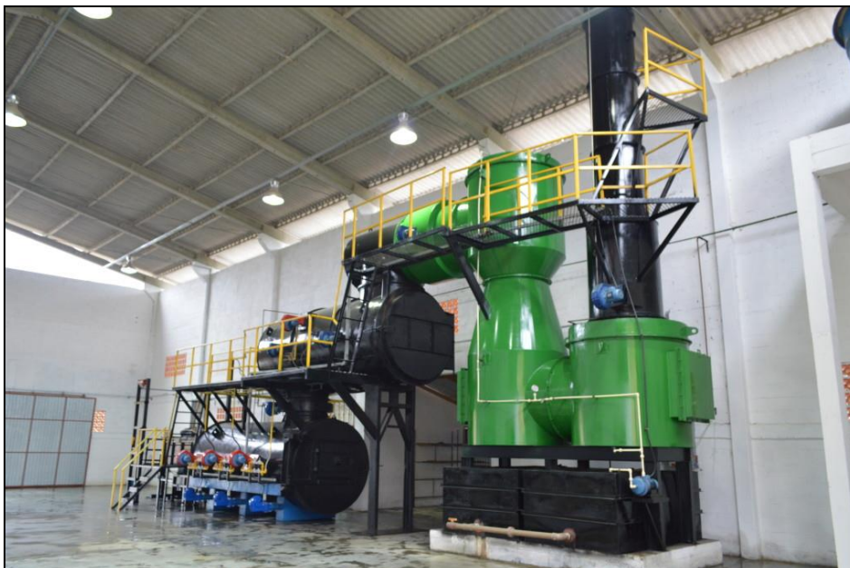
Figura 48 – Aterro da Empresa Hera Sul (incinerador para tratamento dos RSS) Fonte: Empresa Hera Sul, 2019.
