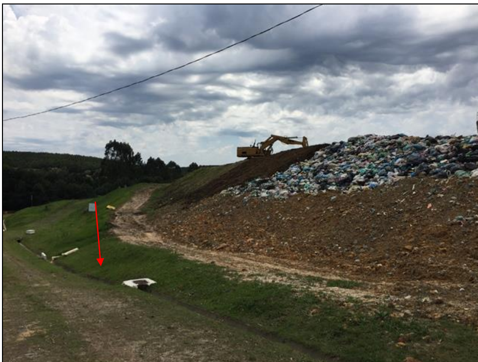
Figura 42 – Aterro sanitário municipal (dreno de águas pluviais) Fonte: Premier Engenharia, 2019.
