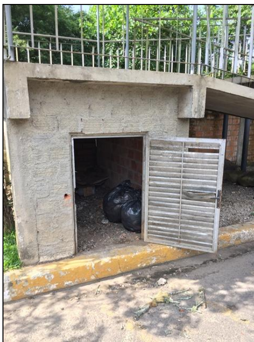
Figura 35 – Armazenamento externo do terminal rodoviário
