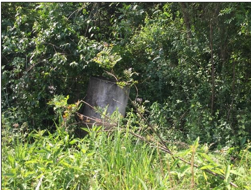
Figura 40 – Área da antiga disposição final de RSU no município (tubulação instalada para monitoramento)
