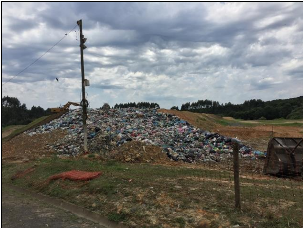
Figura 28 – Atual frente de serviço do aterro sanitário municipal Fonte: Premier Engenharia, 2019.
