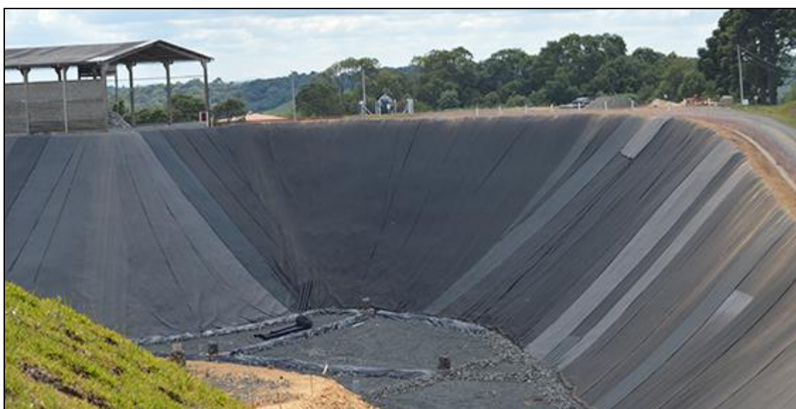
Figura 47 – Aterro da Empresa Hera Sul (célula de disposição de resíduos Classe II)
